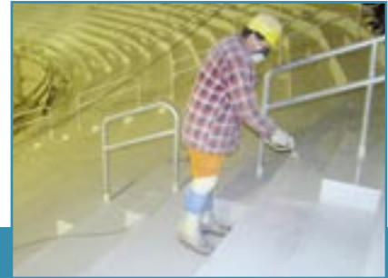
Напыление безвоздушным распылителем
