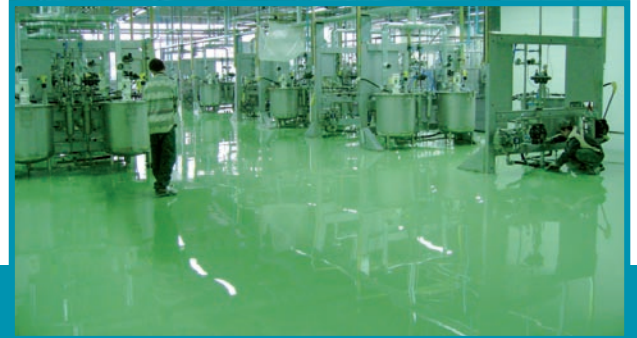
ROMPOX® 1107 ESD-покрытие в производственной зоне для смешивания краски • ROMPOX® 1107 ESD coating in production area for paint mixing • ROMPOX® 1107 ESD-Beschichtung im Produktionsbereich für Farbmischung
