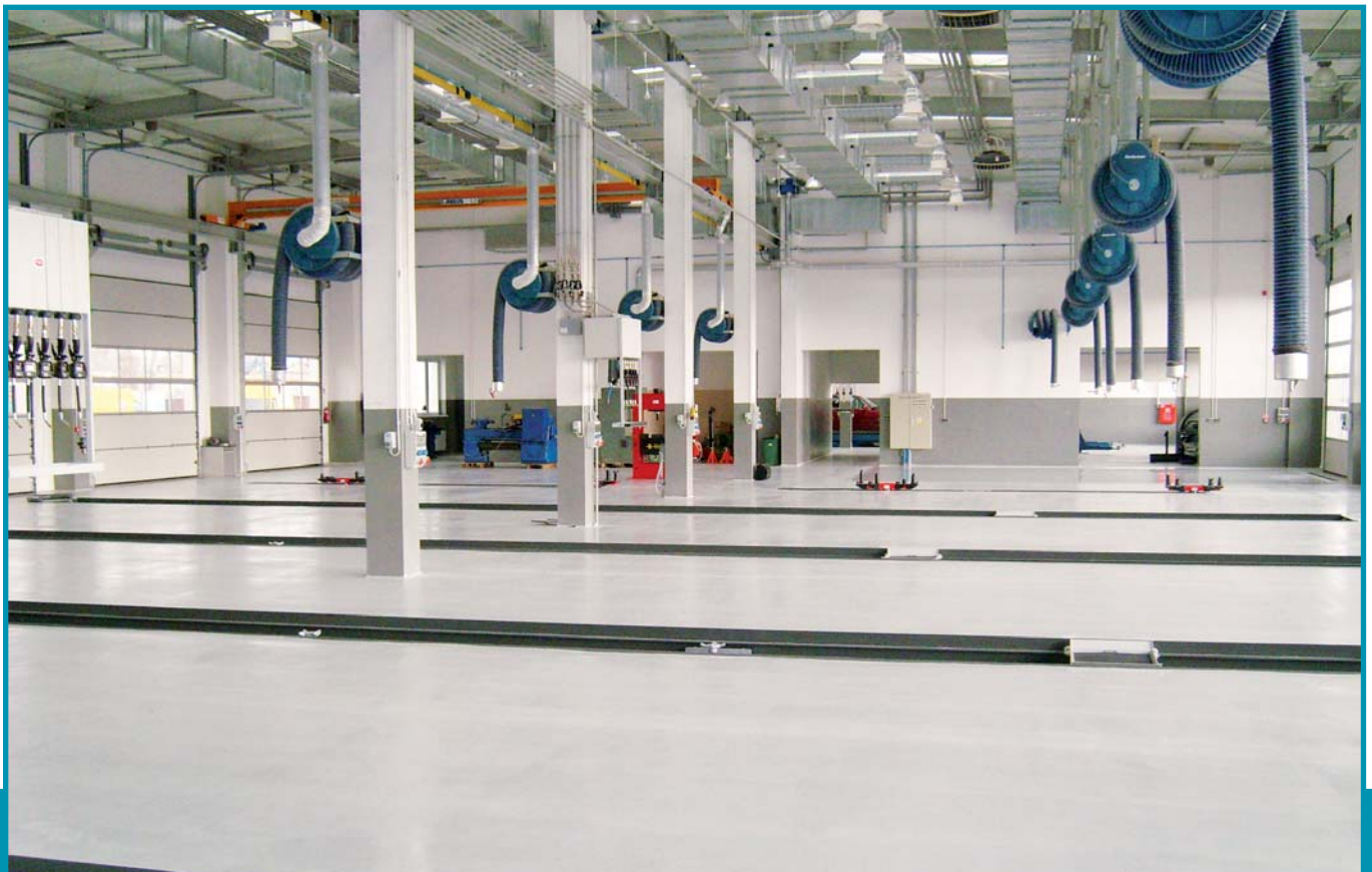
3-4 mm posadzka antypoślizgowa, odporna na duże obciążenia - ROMPOX® I 005, kolor RAL 7035 jasnoszary • 3-4 мм нескользящее, выдерживающее высокие нагрузки покрытие ROMPOX® I 005, RAL 7035 светло-серый, для нагрузки от грузовых автомобилей
