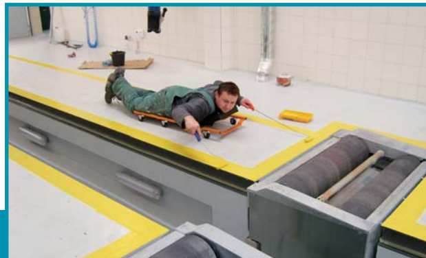
Precyzyjne nanoszenie pasów zabezpieczających ROMPUR® 2450 – pełne zaangażowanie • Прецизионное нанесение разметочных линий материалом ROMPUR® 2450, при использовании всего тела
