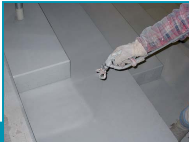
ROMPOX® 1009 Open to steam diffusion sealant – application using airless spray guns • ROMPOX® 1009 Пародиффузионная запечатка – Напыление посредством безвоздушного распылителя
