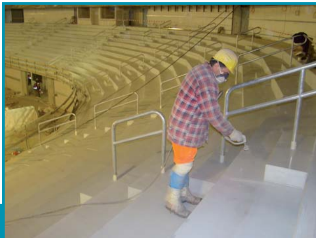
ROMPOX® 1009 Open to steam diffusion sealant – application using airless spray guns • ROMPOX® 1009 Пародиффузионная запечатка – Напыление посредством безвоздушного распылителя
