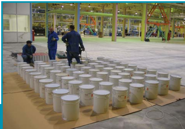
Подготовка под покрытие • Preparation for coating • Vorbereitung zur Beschichtung
