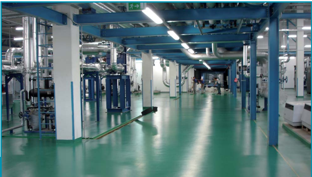
Покрытие ROMPOX® 1507 RAL 6024 зеленый, в новом производственном цехе «Ханкоок» • ROMPOX® 1507 Coating RAL 6024, traffic green in a new production hall at Hankook
